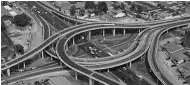
Xây dựng cầu vượt tại Bờ Biển Ngà
