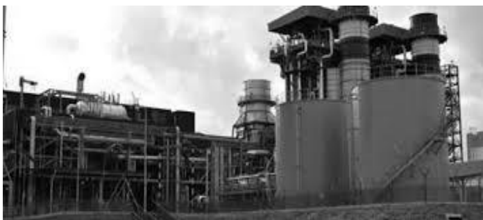
Nhà máy điện ở Bờ Biển Ngà
